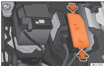
Billede 170 I motorrummet: afdækning på sikringsboks
