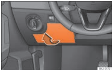
Fig. 64 Instrumentpanelet i førersiden: afdækning på sikringsboks
