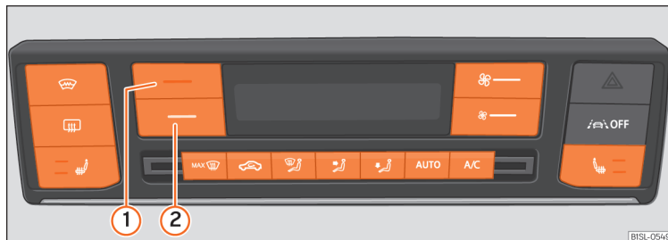
Fig.109 I midterkonsollen: betjeningsselementer til Climatronic
